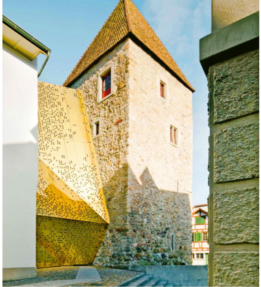
Der Zwischenbau ist zweiseitig: Die rückwärtige Dachfläche bleibt volumetrisch mit dem ehemaligen Zwischenbau identisch und die prominente Stadtansicht vom See aus unverändert. Die Vorderseite, also die Fassade zur Gasse hin, wird geprägt durch eine schräg nach unten gezogene Dachfläche, die sich an die bestehenden Fassaden anpasst, auf diese reagiert, und dabei keinen der bestehenden Übergänge und keines der Fenster schneidet.
